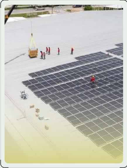
WORKERS INSTALLING SOLAR PANELING ON THE ROOF OF A LARGE WAREHOUSE
